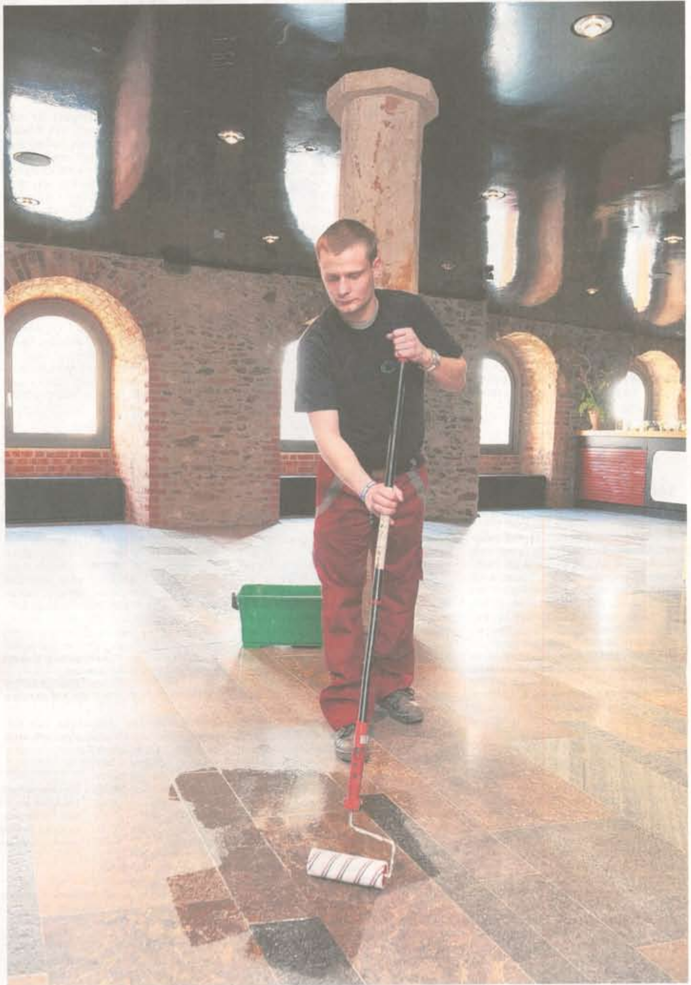
Fußbodensanierer Norman Köhler demonstriert das Verfahren im Schloß Großenhain. Die Beschichtung wird nach der Bodenreinigung einfach mit einer Rolle aufgetragen.
